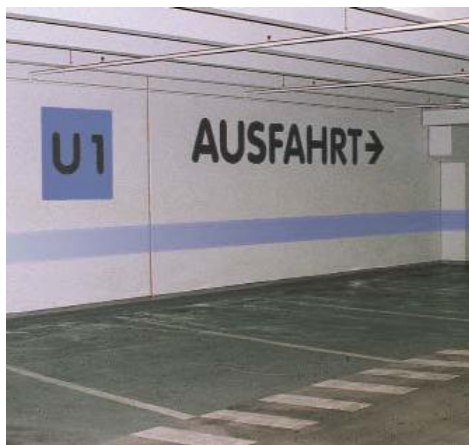
Betonwand im Parkhaus - Beschriftung mit RAUroll- Schablonenfolie mit Standardschrift
